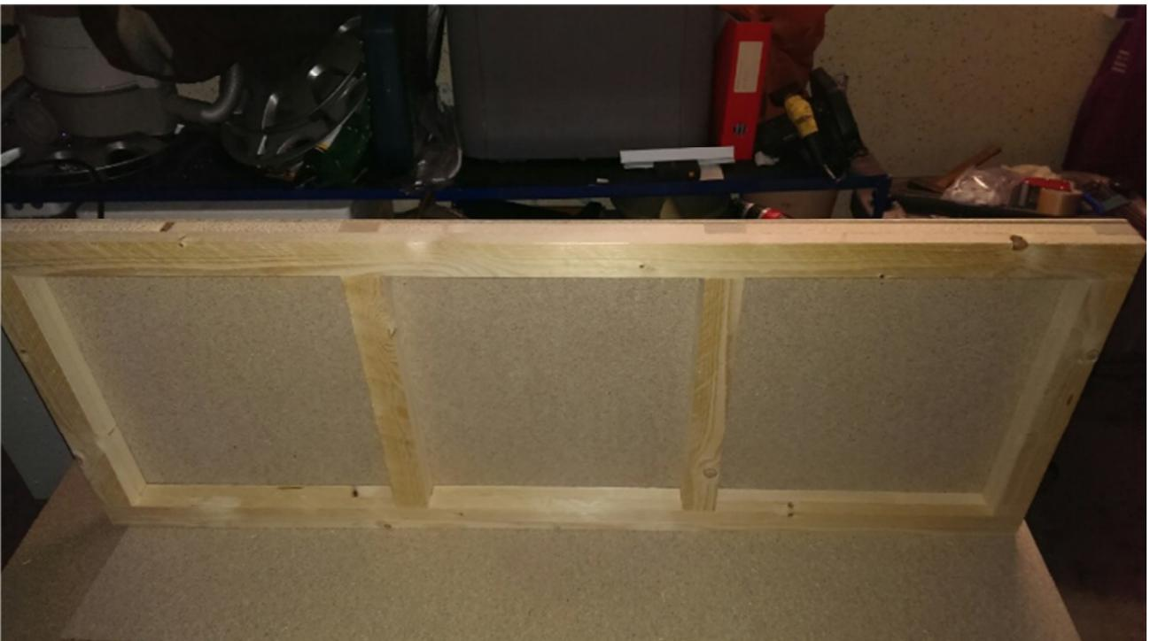
Anschließend wird eine Spanplatte oder Faserplatte auf das Gerüst verschraubt und verleimt.
